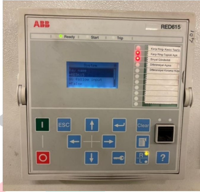
Şekil 11 - M4 Metro suna Ait Diferansiyel Röle
